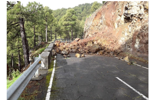
Nevada en el ORM, incendio cerca de los telescopios y desprendimientos en la carretera de acceso al Observatorio.
