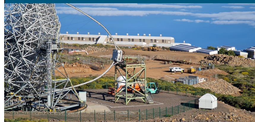
Telescopio LST-1 del grupo Cherenkov Telescope Array (CTA) en primer plano, frente a los trabajos de obra civil para la instalación de la segunda unidad del mismo tamaño en el Observatorio del Roque de los Muchachos, en junio de 2023. Al fondo, la Residencia del Observatorio. © Julio A. Castro-Almazán
