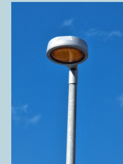
Luminaria certificada por el IAC con filtro ámbar para impedir la emisión de luz azul. © Federico de la Paz (OTPC).
