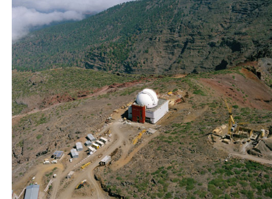
Distintas fases en la construcción de la cúpula del telescopio Isaac Newton en el Observatorio del Roque de los Muchachos © ING
