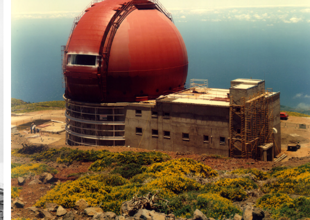
Distintas fases en la construcción de la cúpula del telescopio William Herschel en el Observatorio del Roque de los Muchachos © ING
