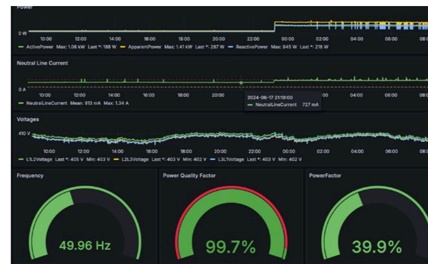
El nuevo control de potencia STELLA. Su núcleo se basa actualmente en PLC fabricados por Beckhoff y permiten una gestión avanzada de la energía. Se muestran 24 horas de potencia, corriente de línea neutra y voltaje según suministrado a los telescopios el 18 de junio de 2024.
