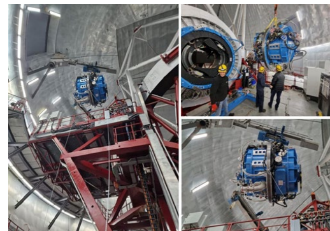
Desmontaje de EMIR en la estación focal Nasmyth A para trasladarlo al laboratorio del GTC.
