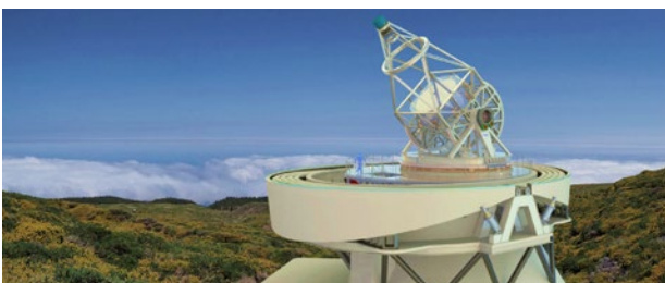
Representación de EST en el ORM (diseño preliminar, parte superior del pilar, estructura y cúpula abierta).
