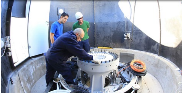
Instalación de la montura del TMS.
