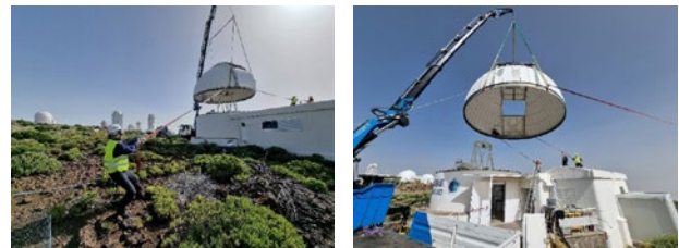
Dos momentos de la reparación de la cúpula del Telescopio TCS.
