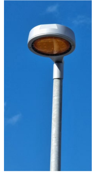
Sustitución de luminarias con filtro ámbar certificado por el IAC.
