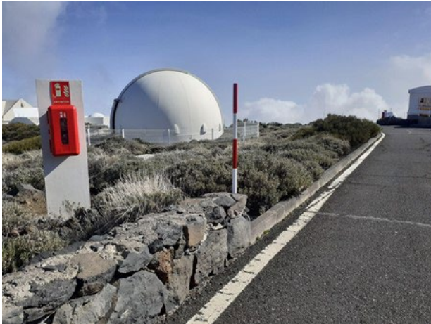
Soporte con su armario y con el extintor polivalente en su interior (IAC).
