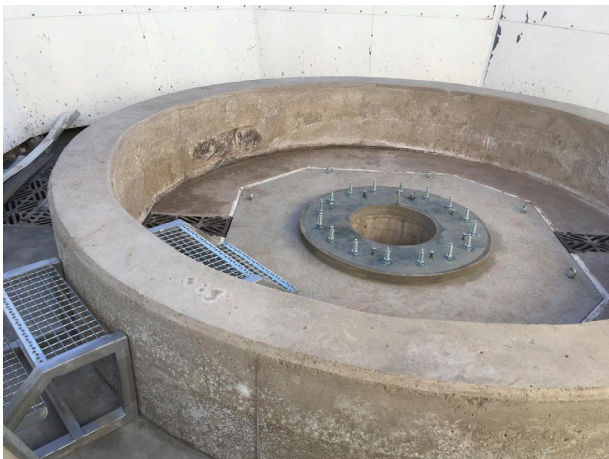
Cimiento del TMS.
