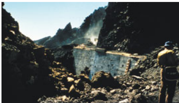
Obras de la carretera de acceso al Roque de los Muchachos. Se pueden ver las máquinas trabajando en el paso de los Andenes. (Foto 32)
