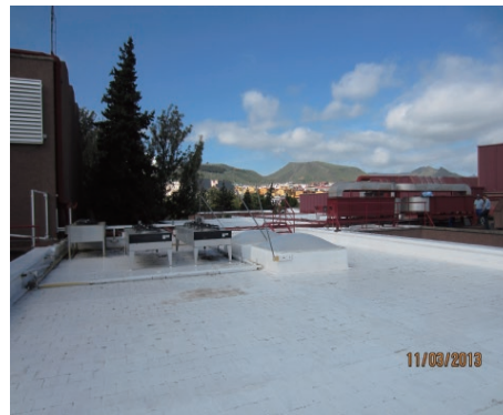
De arriba a abajo: Acceso ambulancia – depósito aéreo de gasoil – impermeabilización de azoteas.
