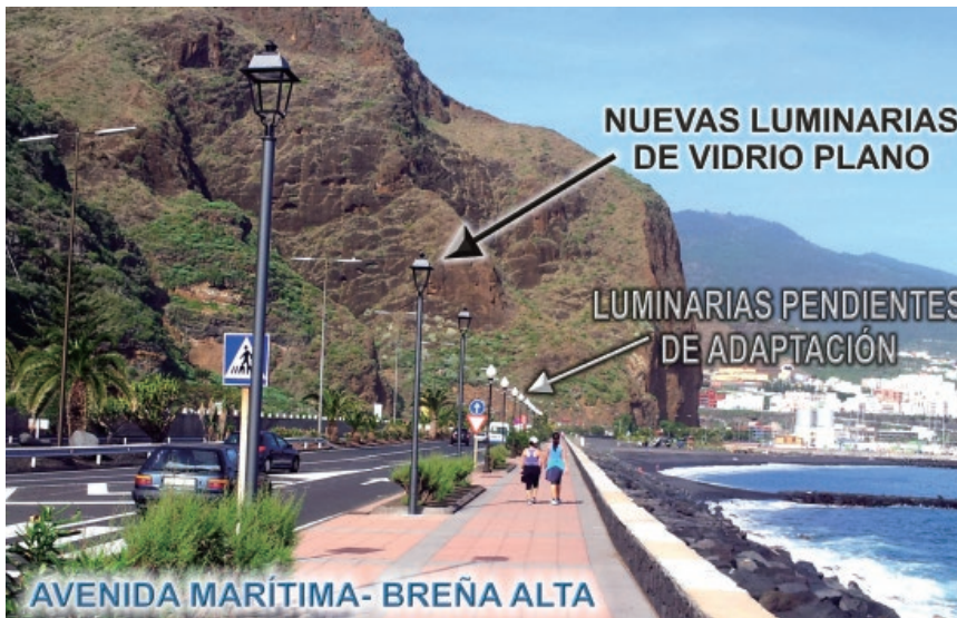
Nuevas adaptaciones de alumbrado en la Avenida marítima de Breña Alta.
