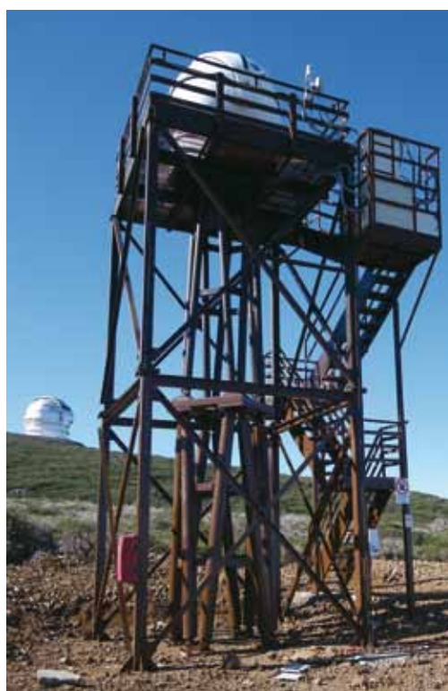
Torreta de 9.2 metros de altura instalada en las proximidades del telescopio MAGIC en el Observatorio del Roque de Los Muchachos, con el instrumento ubicado dentro de la cúpula en la parte superior de la misma.
