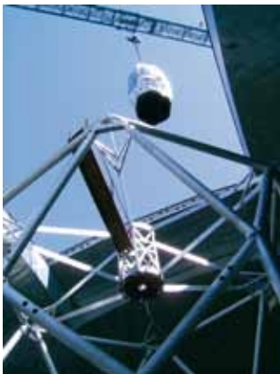
A la izquierda, la grúa procede a introducir la torre del espejo terciario a través de las compuertas de observación. A la derecha, la torre del espejo terciario está situada en el centro del espejo primario.
