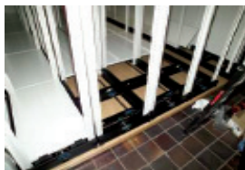
Reestructuración sala de revistas: Montaje de las estanterías móviles.
