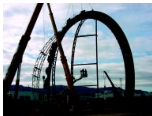
Imágenes de la construcción de la cúpula del GTC en las instalaciones de la empresa URSSA, en Vitoria.
