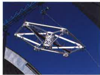
De arriba abajo: tubo antes de la instalación de la araña; introducción de la araña del secundario del GTC a través de la compuerta de observación; y grúa transportando la araña del GTC. Créditos: IAC.
