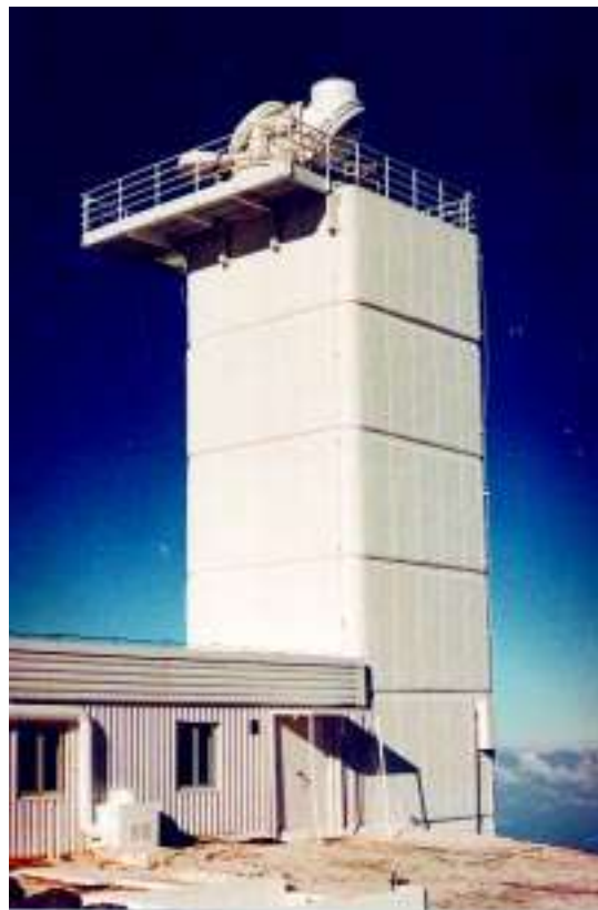
Torre solar sueca (SST), telescopio al vacío de 1m de diámetro, en cuyo sótano se encuentra la sala de control de SDIMM. Foto: Noel Torres Taño (IAC).
