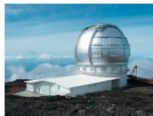
El GTC, en construcción.
